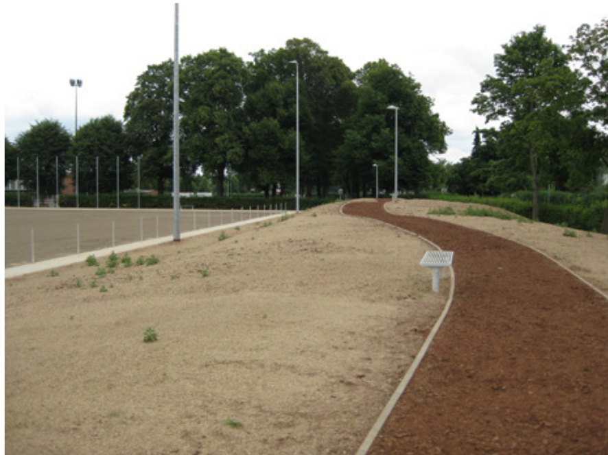
Die westlich gelegenen Rasenflächen werden zu Trainingsfeldern ausgebaut
