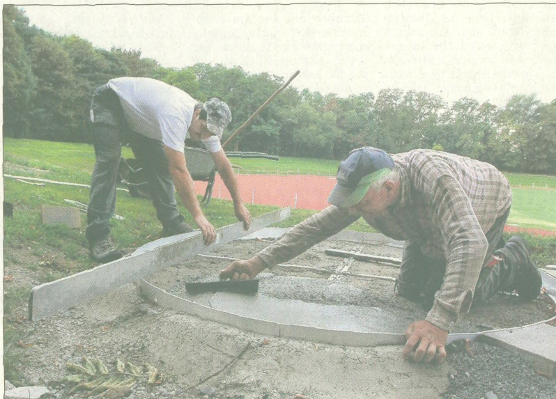
Letzte Arbeiten an der Buchenau-Kampfbahn: Peter Krieger und Franz-Josef Rabanus streichen den Kugelstoßring mit Beton aus.
