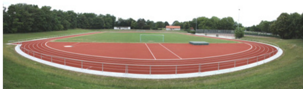
Für rund 720.000 Euro wurde die Laufbahn erneuert Alle Bilder: SIG – Hessen Ingenieure
