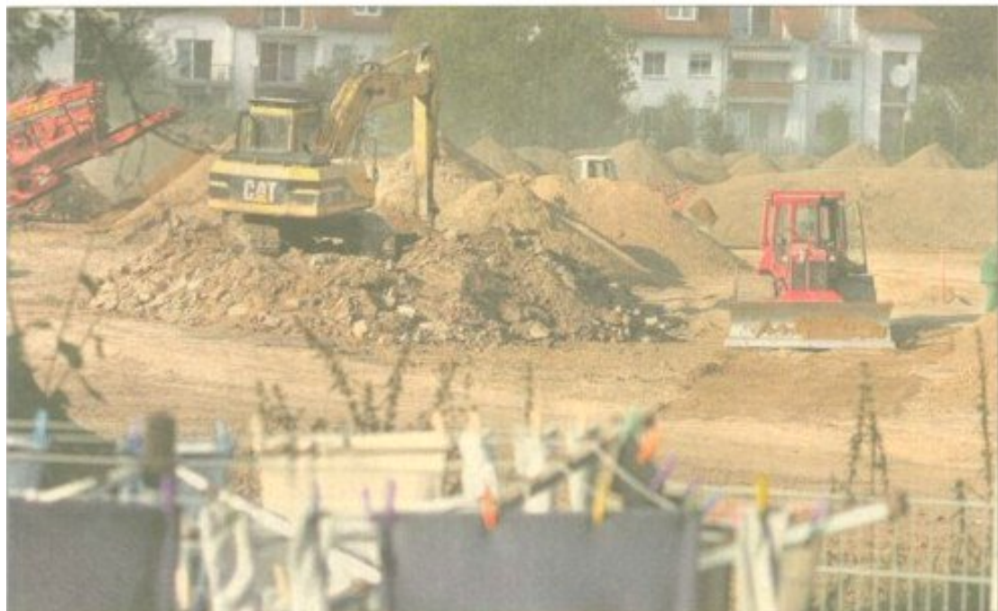
Baustopp: Gestern roffen noch die Bagger im Nordstadstadion, aufgenommen von einem Garten an der Grebensteiner Straße. Das Verwaltungsgericht hat den Umbau und die Erweiterung der Sportanlage nun aber durch einen Beschluss gestoppt. FOTO: BERGER
