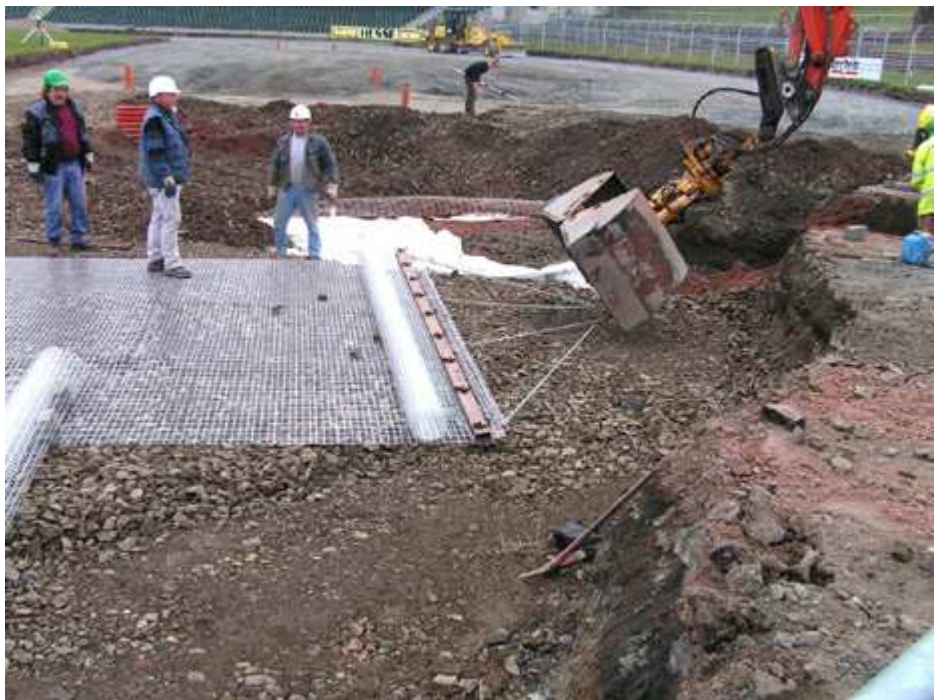
20.000 Quadratmeter Geogitter wurden verwendet. Bild: SIG – Hessen Ingenieure
